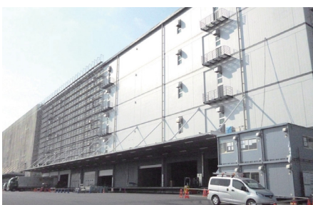
● 外壁の改修に!
